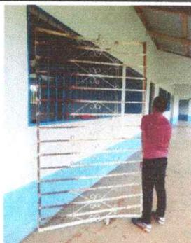
Foto 3: En la imagen se logra apreciar el cambio de los balcones deteriorados por balcones nuevos.
