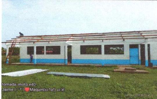
Foto 1: En la imagen se evidencia la desinstalación completa de las láminas deterioradas del techo de la escuela.
